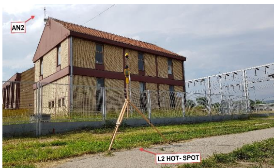
SLIKA 2. TRANSFORMATORSKA STANICA "NOVI SAD 7" LOKACIJA L2
